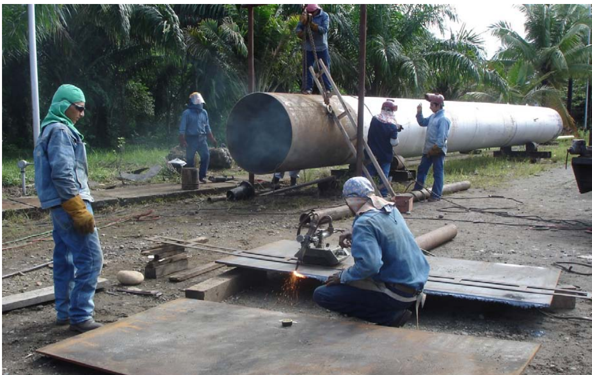
Proceso de soldadura exterior y corte de láminas con suelda autógena, contaminación de los recursos aire, suelo, paisajista y flora
