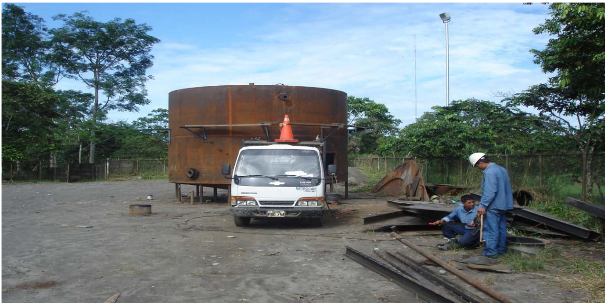
Procesos de montaje y construcción de tanque de 500 barriles, contaminación suelo, flora
