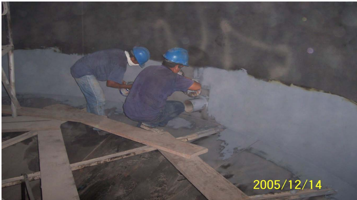
Proceso de Pintura interior de tanque de 500 barriles reparado
