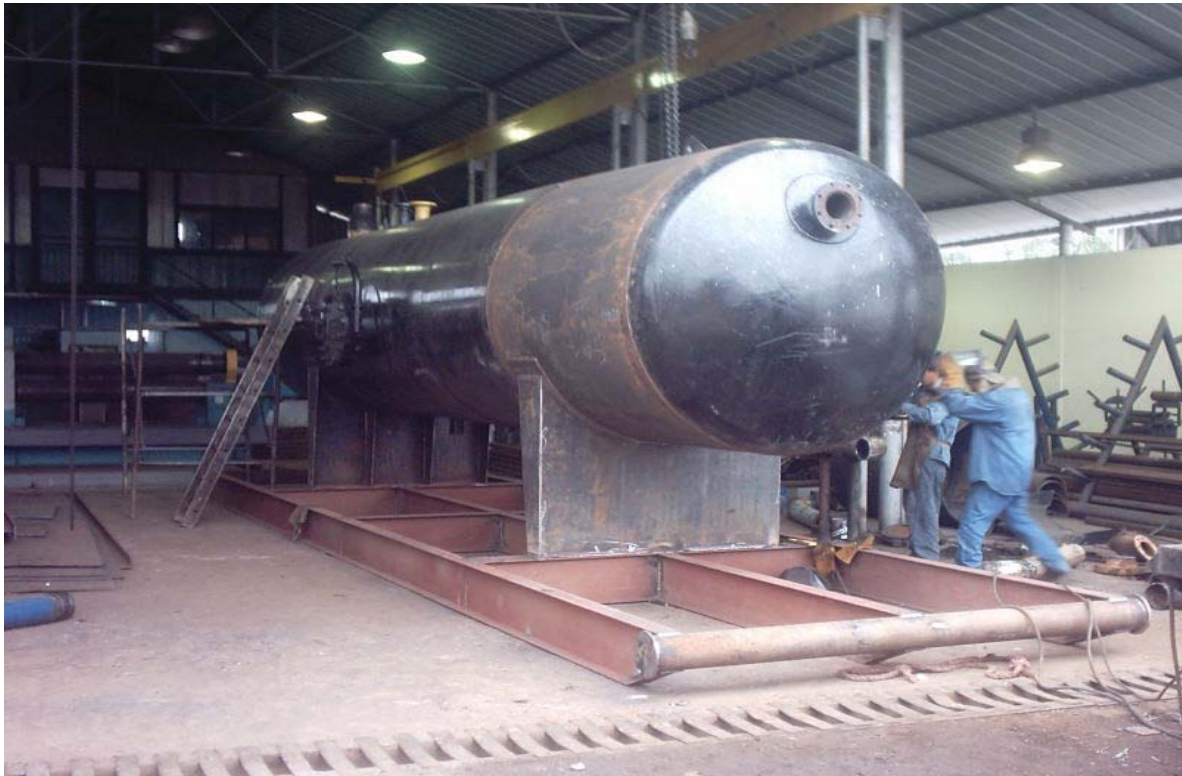
Armado de separador de producción, montaje de partes exteriores
