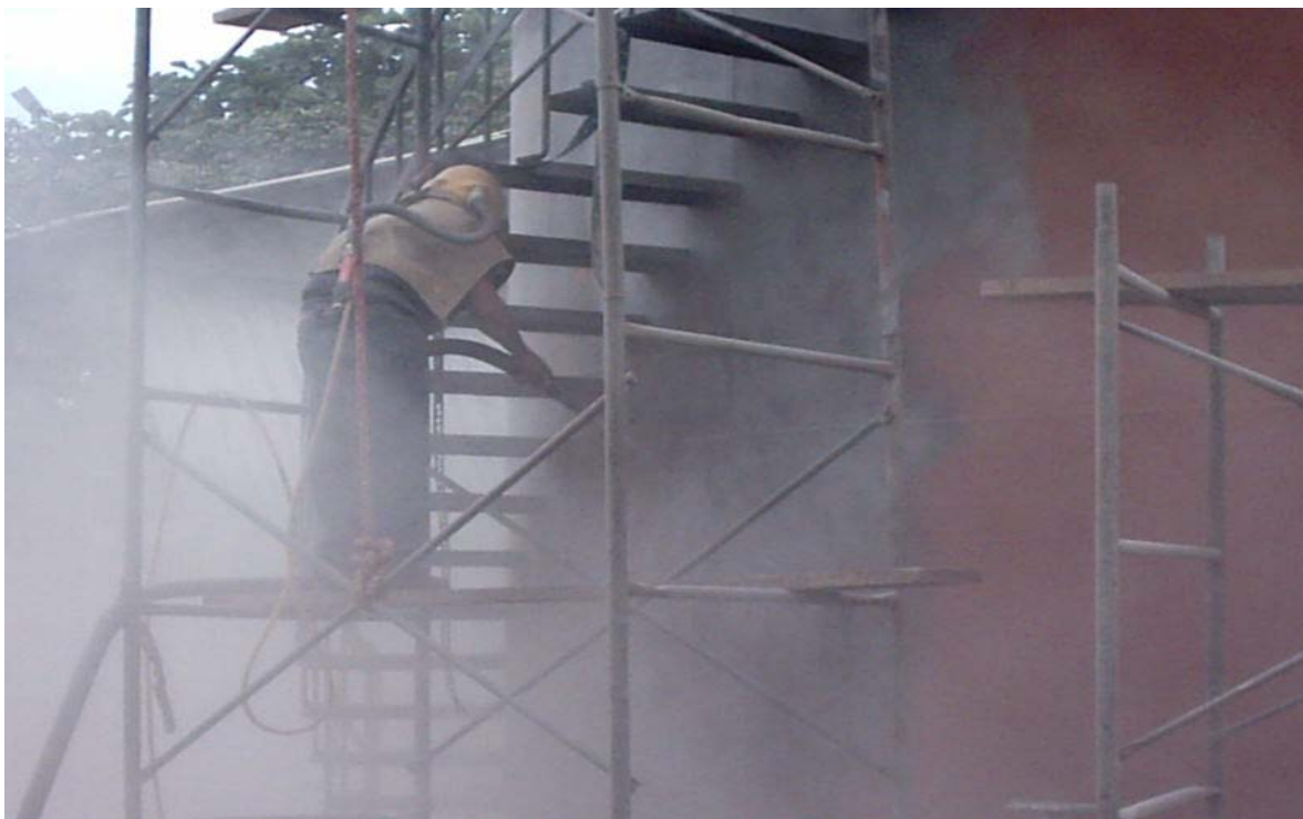
Proceso de limpieza exterior de tanque de 500 barriles de capacidad Limpieza exterior del tanque, sandblasting, contaminación del recurso suelo,aire y ambiente
