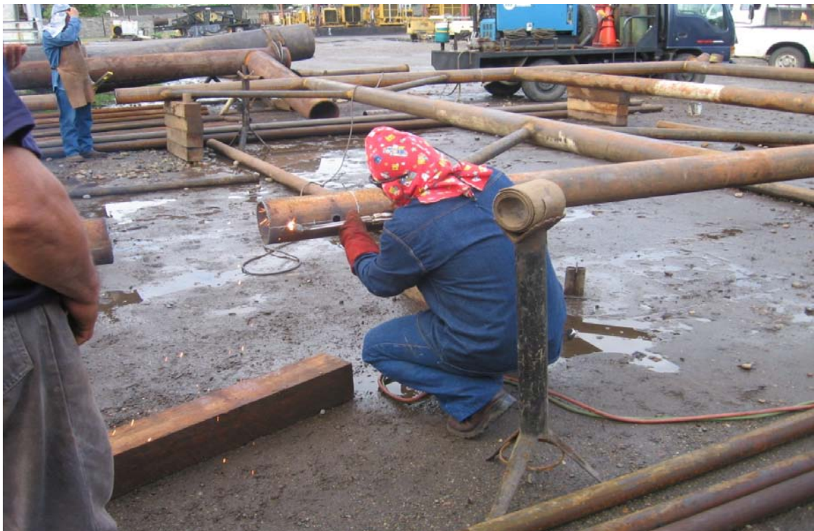
Proceso de montaje de skid, contaminación recurso suelo y aire
