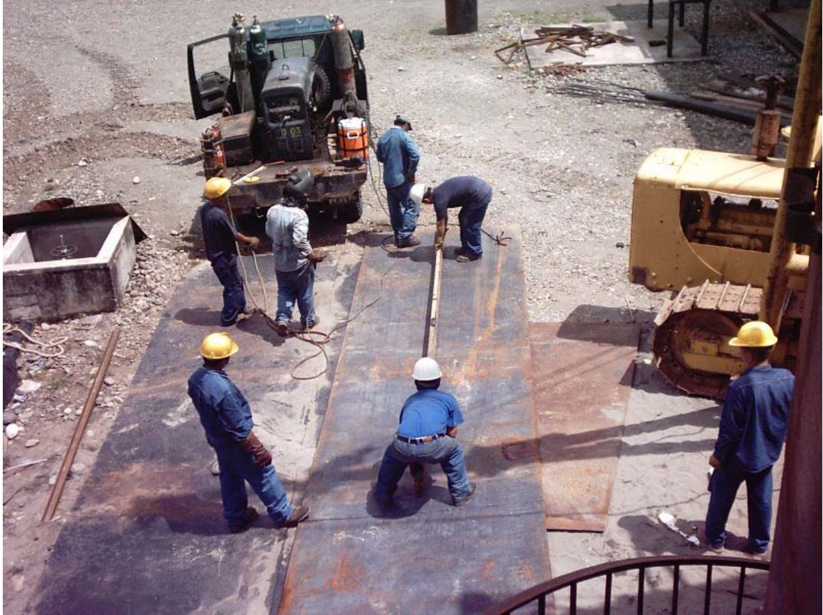
Corte y medición de láminas para reparación de tanque de 500 barriles, contaminación recurso suelo, aire
