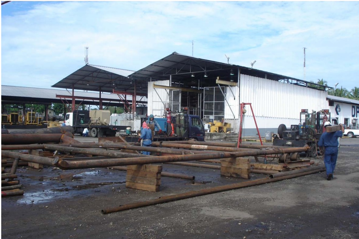
Preparación de skid para tanques y reparación de bota de gas, contaminación del suelo, aire con motores de los equipos de suelda
