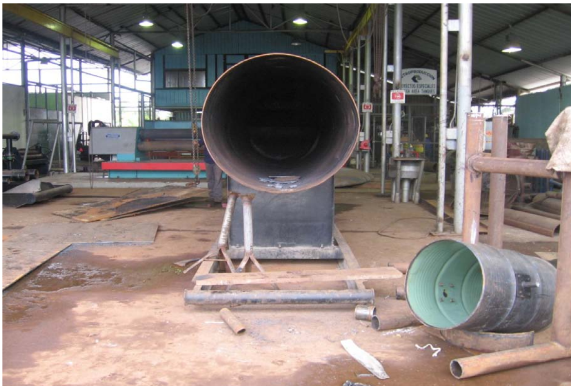
Limpieza y reparacion de separador, contaminacion recurso suelo y ambiente
