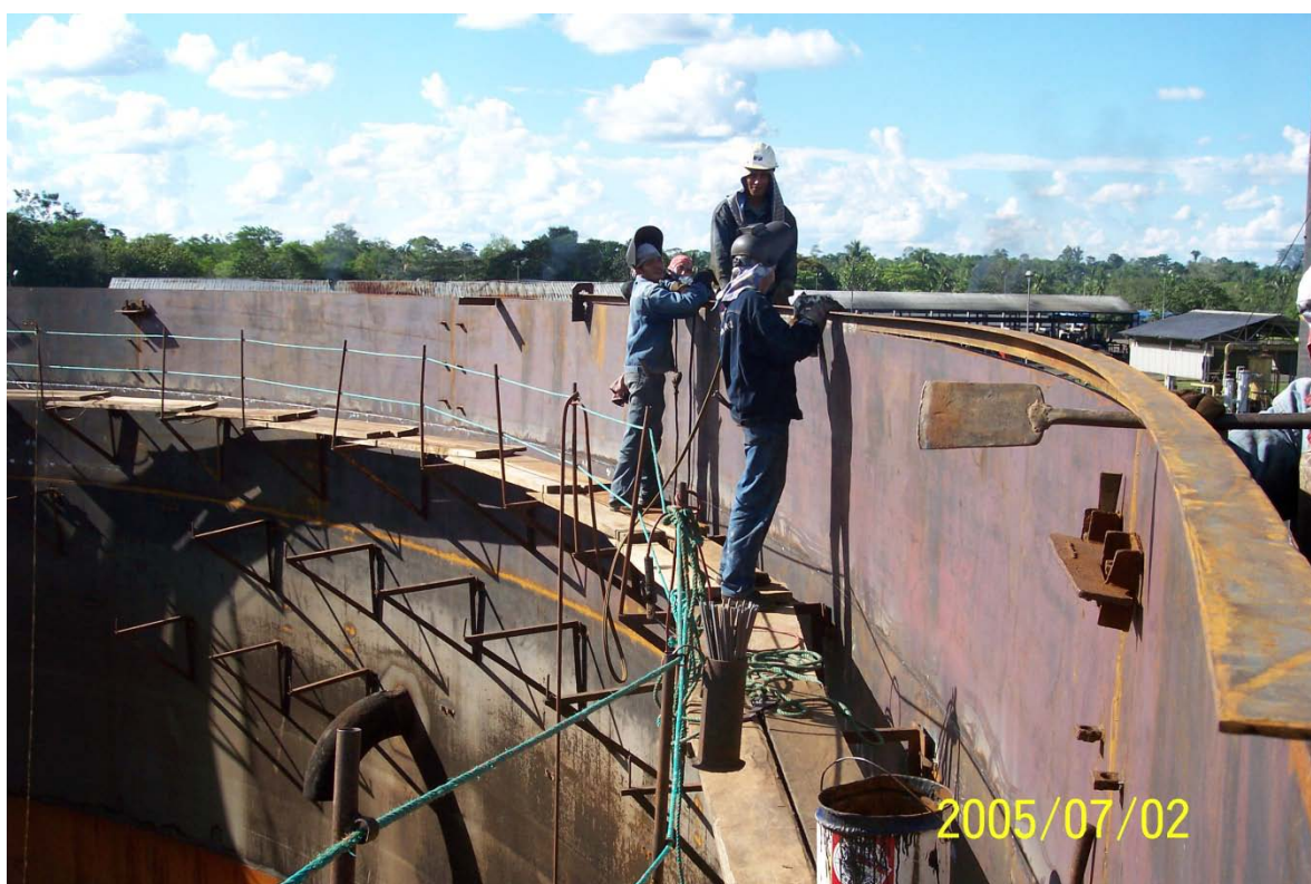
Reparación interna de tanque, colocación de ángulo de tope
