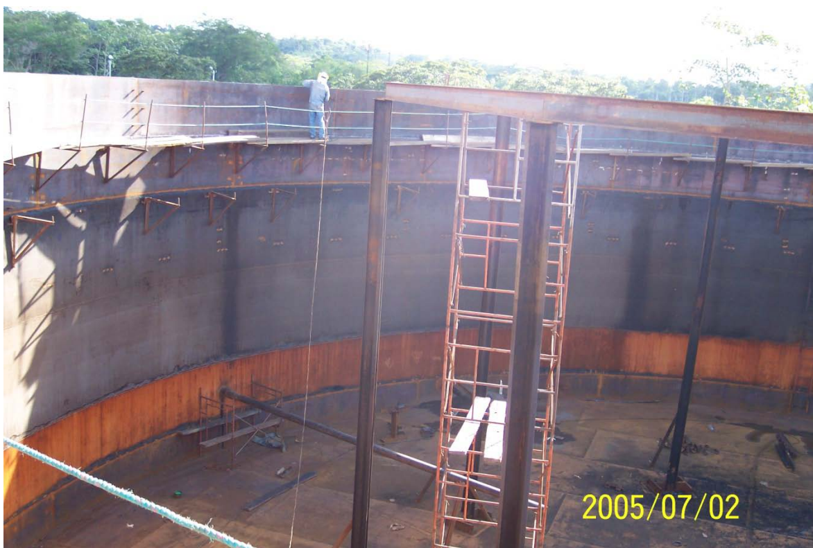
Reparacion interna de tanque, instalacion de vigas para bafles
