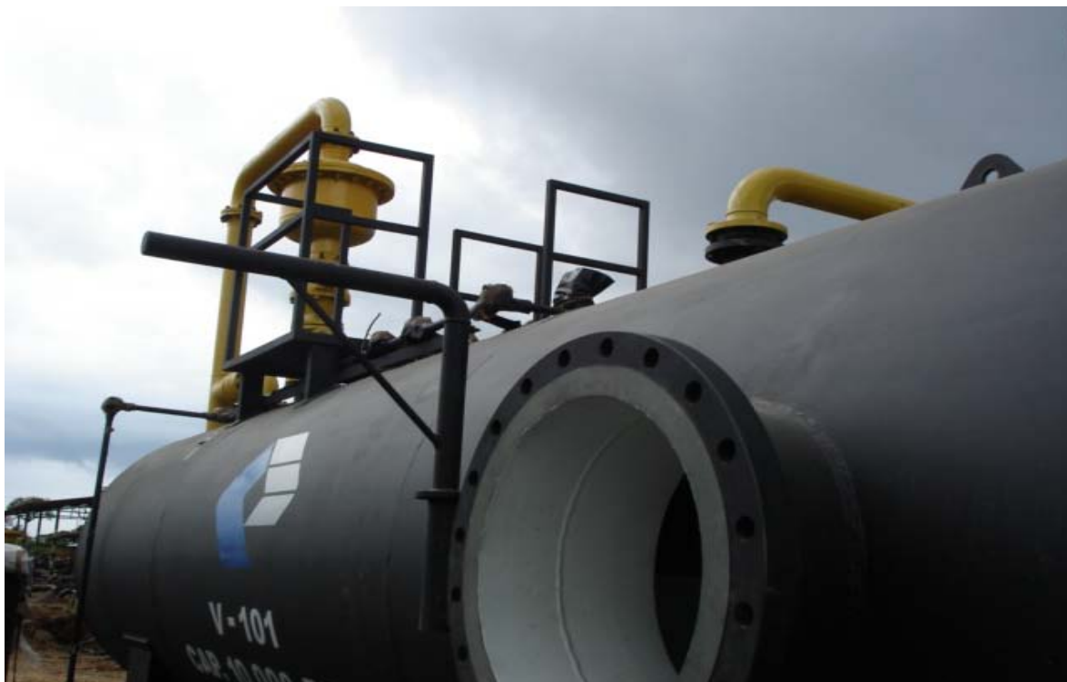
Separador de producción reparado, armando sistemas de control. Montaje en estación de producción
