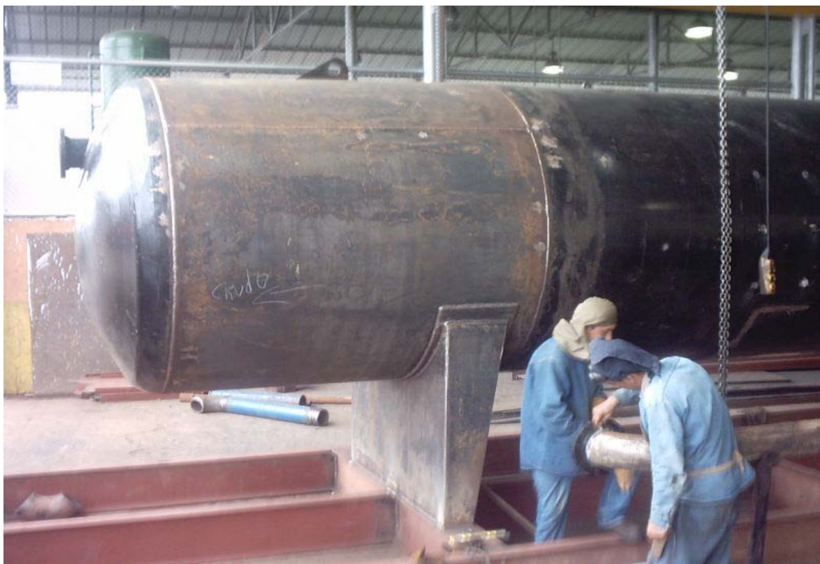
Trabajos de reparacion de separador de 35.000 barriles de capacidad
