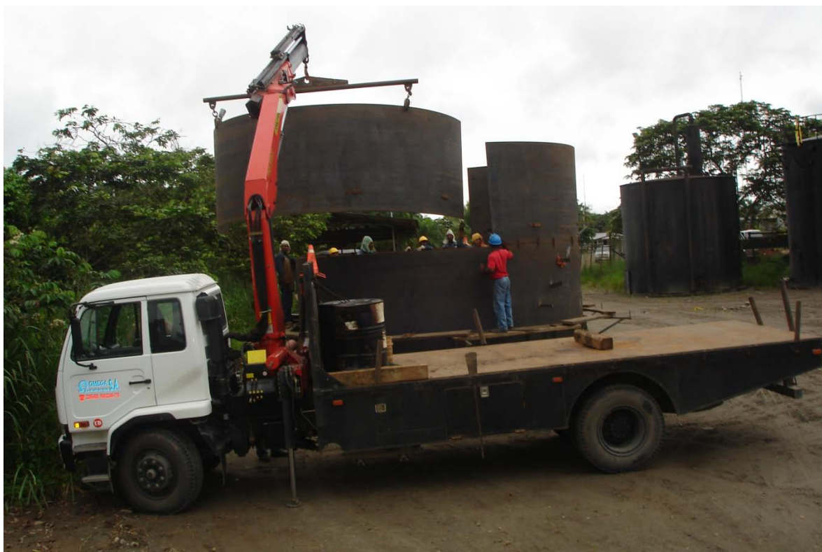
Armado y Montaje de tercera virola de Tanque De 500 Barriles
