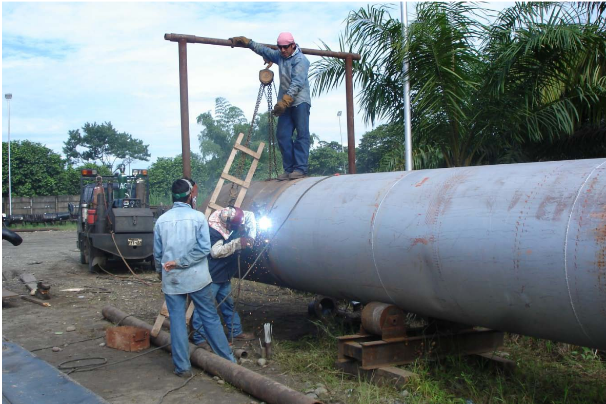
Proceso de soldadura bota de gas, contaminación recurso suelo y aire
