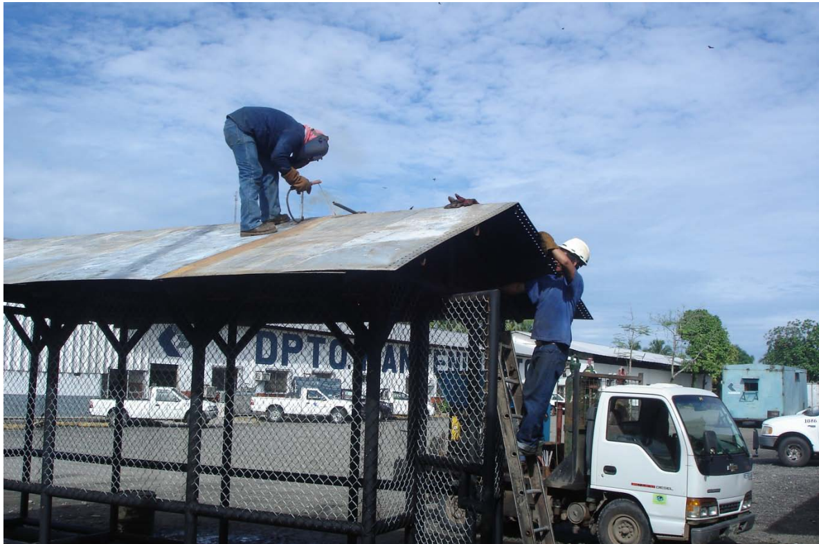
Construcción De Casetas para sal, utilizado en taladros de perforación.
