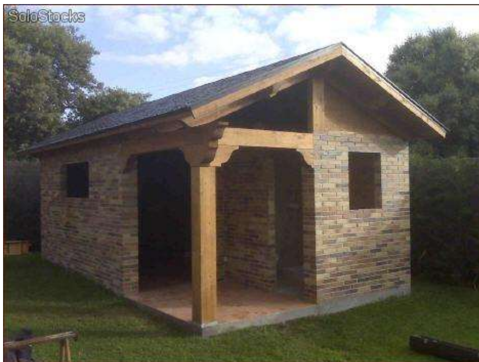
Imagen 2. Cabaña mista de ladrillo y madera
