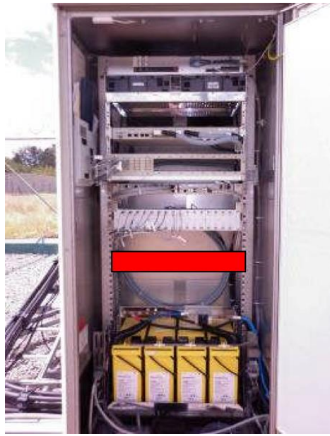
Figura 33. Ubicación de la IDU y DDF dentro del SR2 (opción1)
