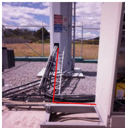
Figura 38. Recorrido del cable de IF por las escalerillas
