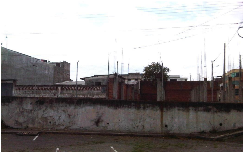
Imagen #27. Vista desfavorable hacia la calle Atahualpa Fuente: Elaboración propia
