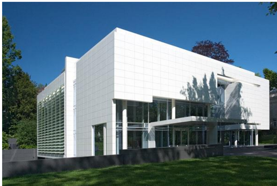
Imagen #13. Percepción exterior de placas blancas, parasoles metálicos y paños de vidrio.
