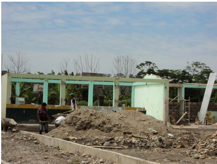
Foto 2: Casa Comunal en remodelación
