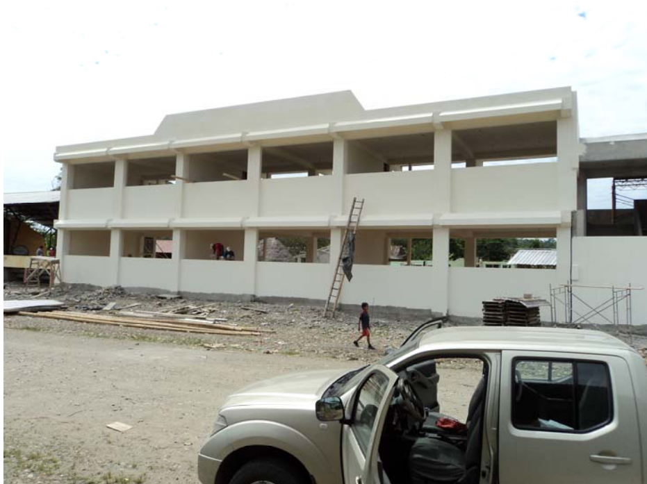
Foto 3: Construcción de la nueva escuela
