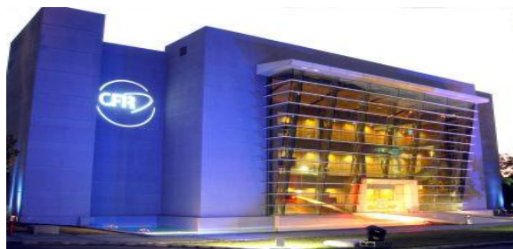
Imagen 2: Primer plano de la Planta Pharmafuturo Recalcine
