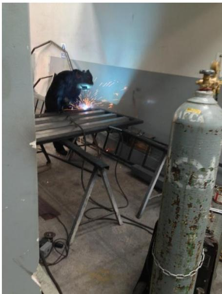
*Figura 33.* Suelda de tubos de la estructura, por Carlos Moscoso (2013).
