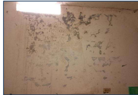
[Eflorescencia - Muro]
