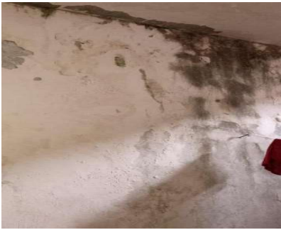
Eflorescencia – Losa- Muro]
