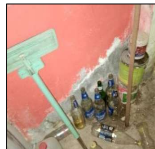
[Eflorescencia - Muro]
