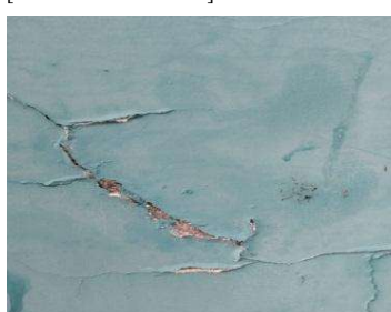
[Eflorescencia - Muro]
