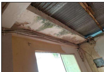
[Eflorescencia - Losa]
