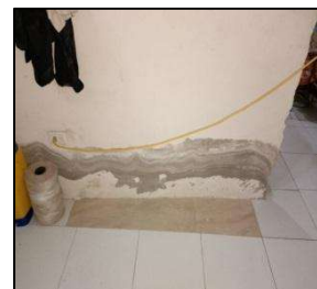
[Eflorescencia - Muro]
