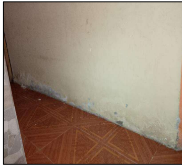
[Eflorescencia - Muro]
