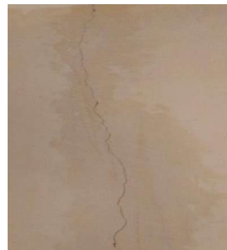
[Fisura - Muro]
