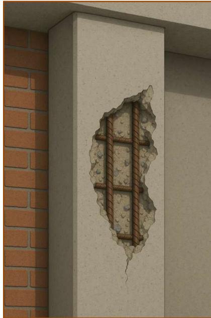
Ilustración 3 Desprendimiento de recubrimiento en columna de hormigón armado.
