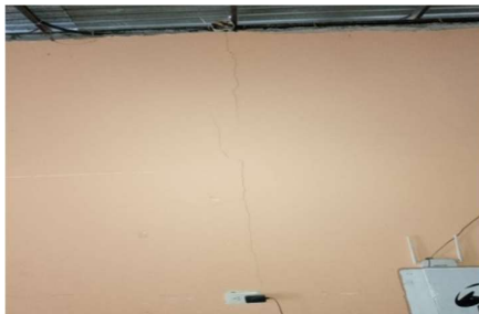
[Fisura - Muro]
