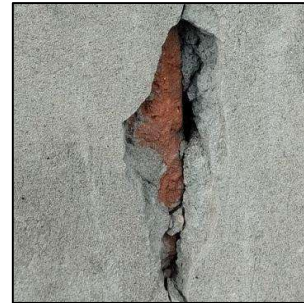
[Desprendimiento - Muro]
