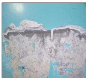
[Eflorescencia - Muro]
