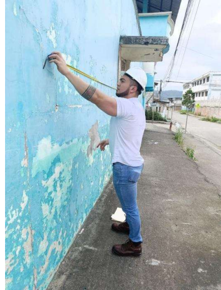
5.4. Medición de elemento estructural (muros) en la vivienda 27, código: 240, calle H y calle 5.
