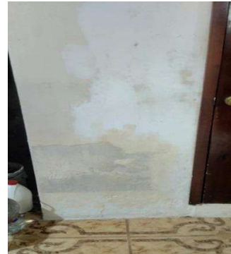
[Eflorescencia - Muro]
