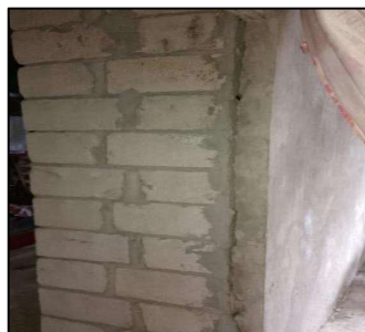
[Fisura - Muro]
