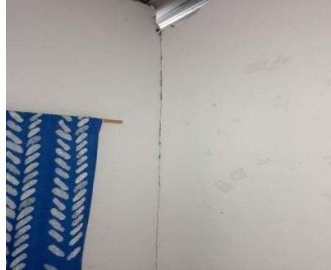
[Fisura - Muro]
