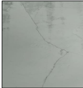
[Fisura - Muro]
