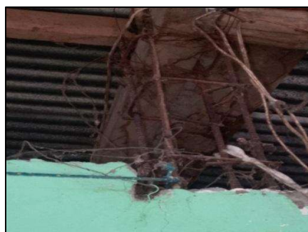
[Corrosión - Columna]
