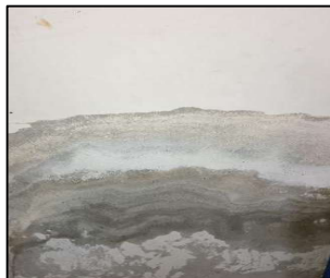
[Eflorescencia - Muro]
