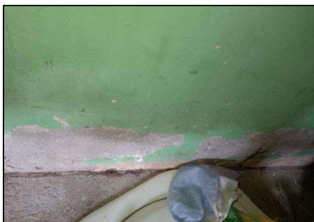
[Eflorescencia - Muro]
