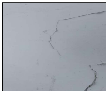
[Fisura - Muro]
