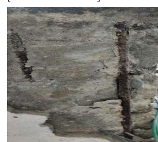
[Corrosión - Columna]
