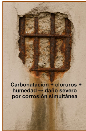
Ilustración 8 Manifestaciones de lesiones combinadas
