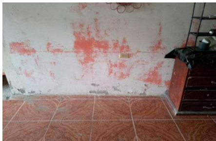
[Eflorescencia - Muro]
