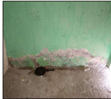
[Eflorescencia - Muro]
