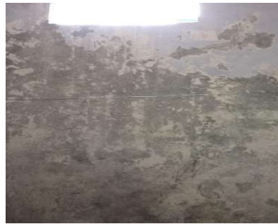
[Eflorescencia - Muro]
