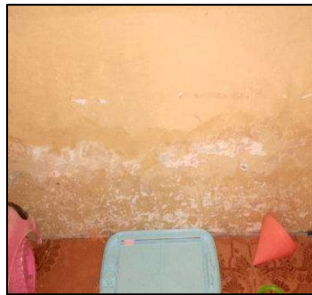
[Eflorescencia - Muro]
