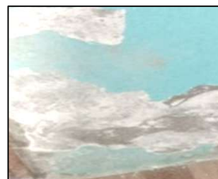
[Eflorescencia - Muro]
