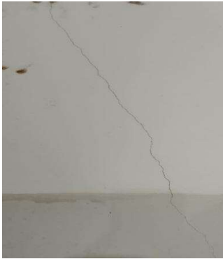
[Fisura - Muro]
