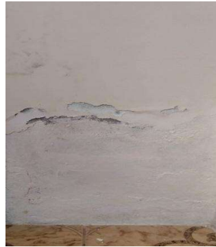
[Eflorescencia - Muro]
