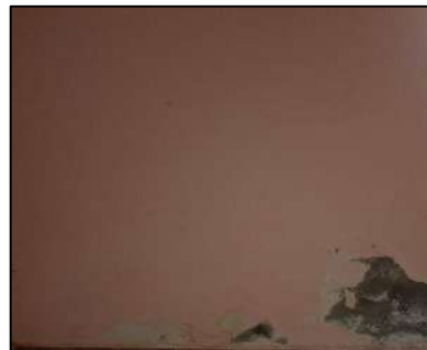
[Eflorescencia - Muro]
