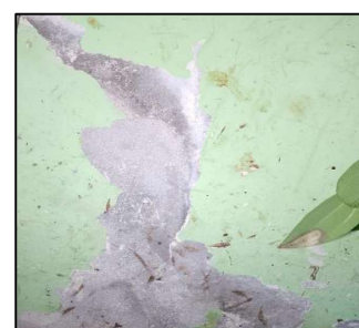
[Eflorescencia -Muro]
