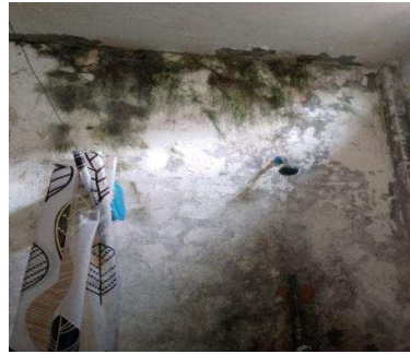
[Eflorescencia – Humedad - Muro]
