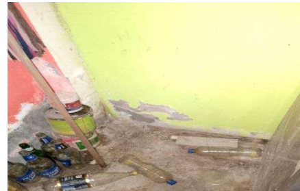
[Eflorescencia - Muro]
