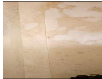
[Eflorescencia - Muro]
