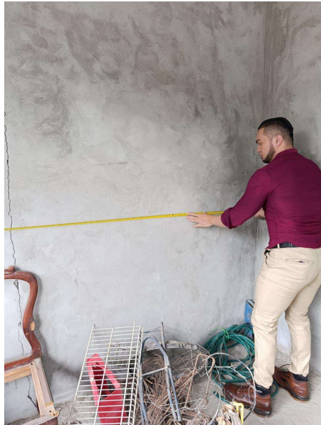
5.7. Medición de elemento estructural (muro) en la vivienda 28, código; 7761, calle H entre calle 3 y calle 4.
