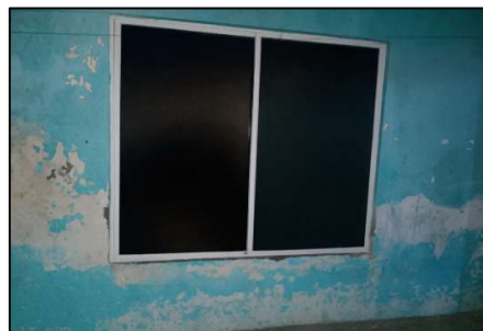
[Eflorescencia - Muro]
