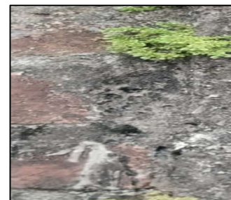
[Eflorescencia – Losa]
