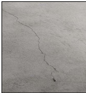
[Fisura - Muro]
