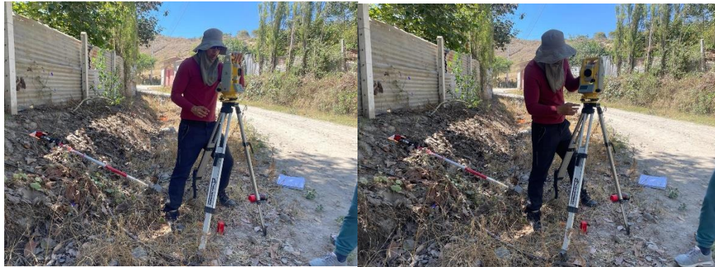
Figura 28. Colocación estación total en campo
