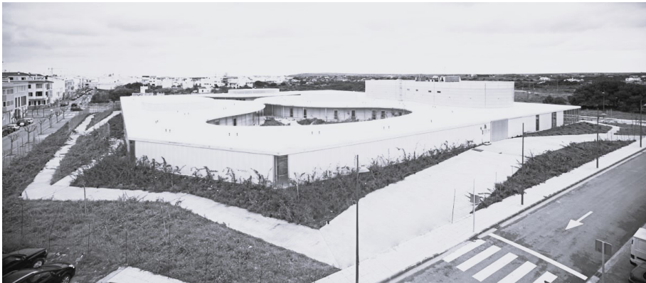
Gráfico 01. Centro sociosanitario geriátrico Santa Rita Fuente: https://www.archdaily.cl/cl/626312/centro-sociosanitario-geriatrico-santa-rita-manuel-ocana
