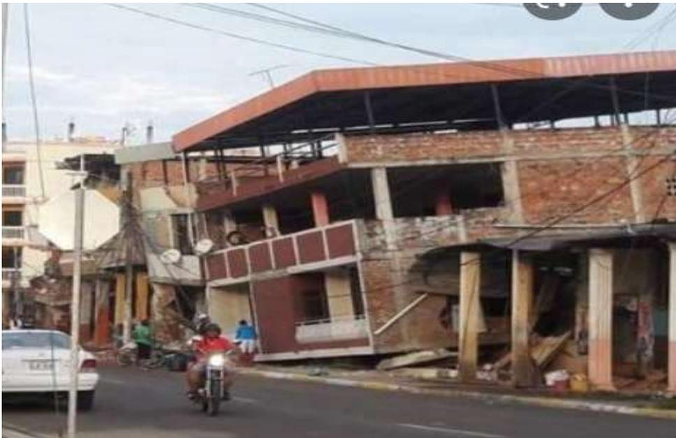
**Ilustración 10.** Irregularidad en elevación en una estructura
