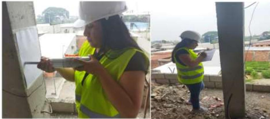
**Fotografía 5.** Ensayo del esclerómetro de la columna del piso 3.
