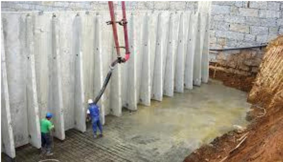
*Ilustración 4. Tablestacas de hormigón.*
