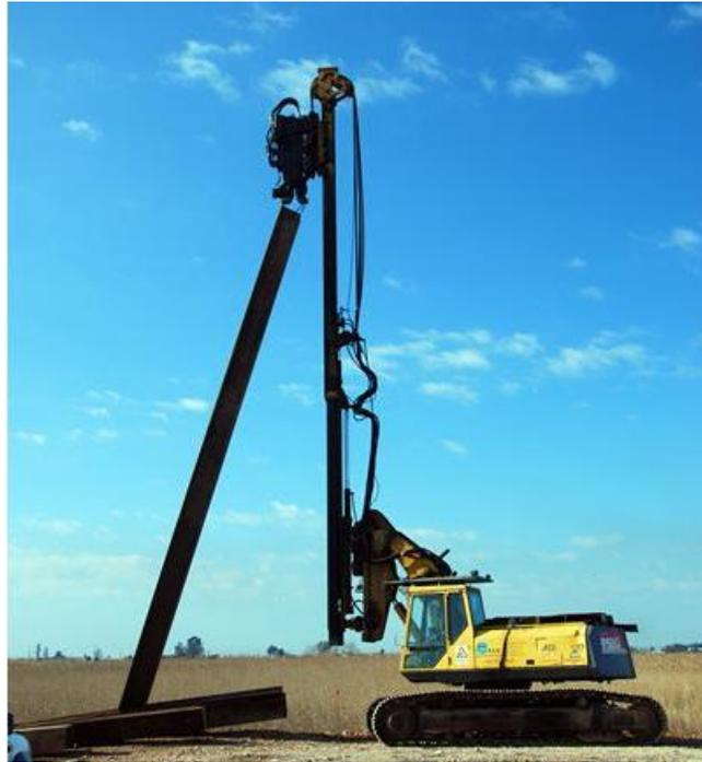
*Ilustración 9. Tablestaca elevada y asegurada con el mástil.*
