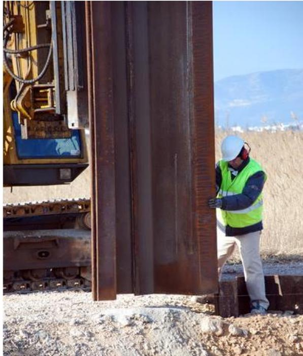
*Ilustración 10. Tablestaca lista para ser hincada.*
