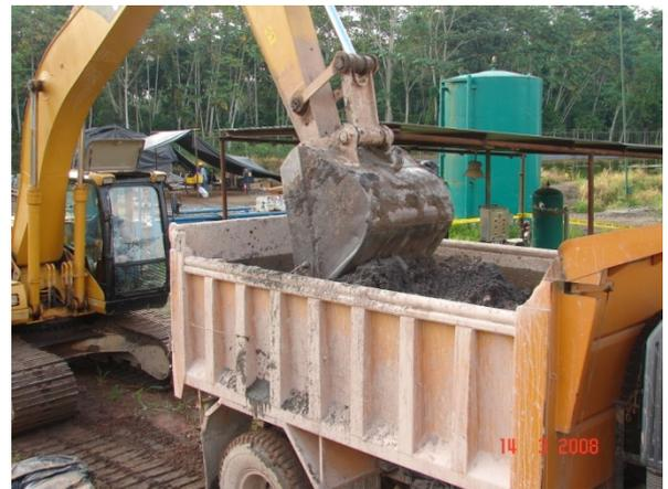
Homogenización previa a disposición
