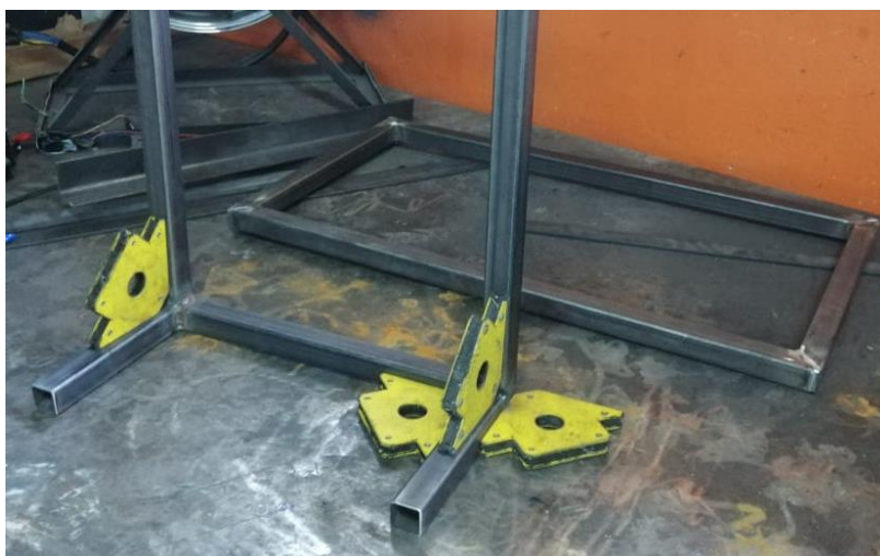
Figura 110. Construcción de los laterales rectos del cubo con ángulos de 90 grados.
