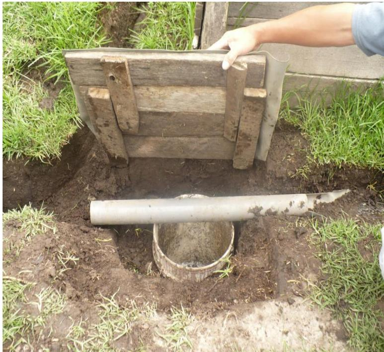
*FOTO 1: Tanques recolectores con la tubería por donde pasan los lixiviados, tapa de madera cubierta con geomembrana para evitar el paso de la lluvia al tanque.*
