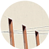
MAMPOSTERÍA DE LADRILLO ENLUCIDA Y PINTADA
