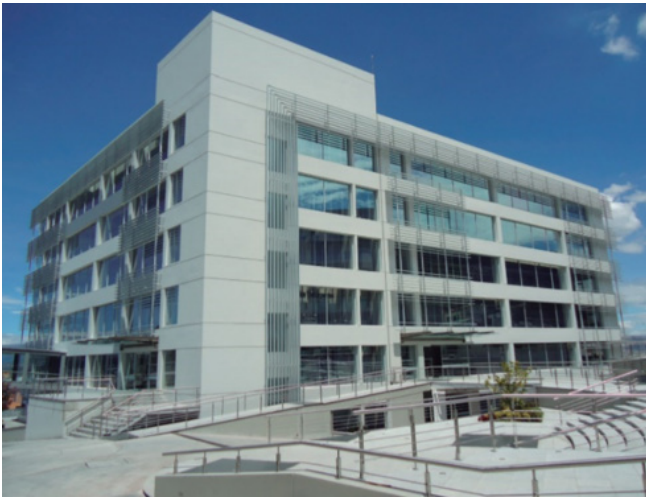
Fotografía 9: Torre Médica I Fuente: núñez arquitectos
