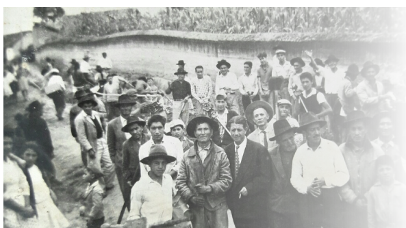
Foto 5. Minga para el alcantarillado en la Calle Simón Bolívar y Av. Quito, año 1950. Foto: Sr. Enrique Jaramillo N.
