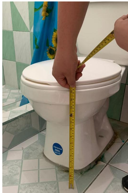
Figura 22: Constancia de la altura del WC inferior a 50 cm.
