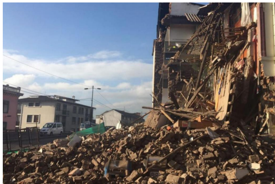
IMAGEN 3: Fotografía de vivienda privada colapsada por falta de mantenimiento en el barrio San Blas
