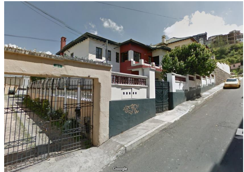
IMAGEN 5: Casa rehabilitada de renta en el barrio “La Tola”
