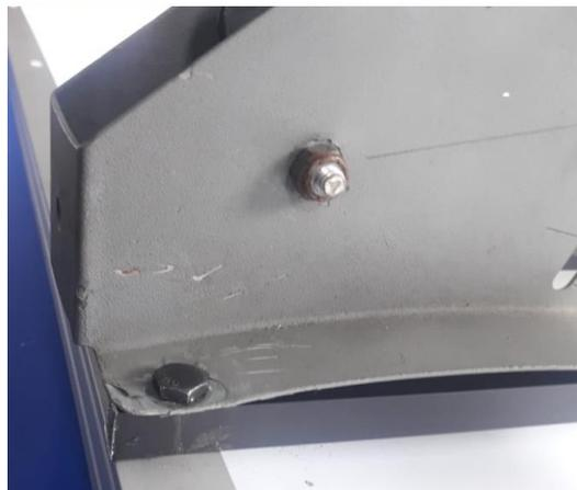
**Figura 46. Sujecion de panel, columna cuadrada y pedestal angular con perno. Autoria propia.**
