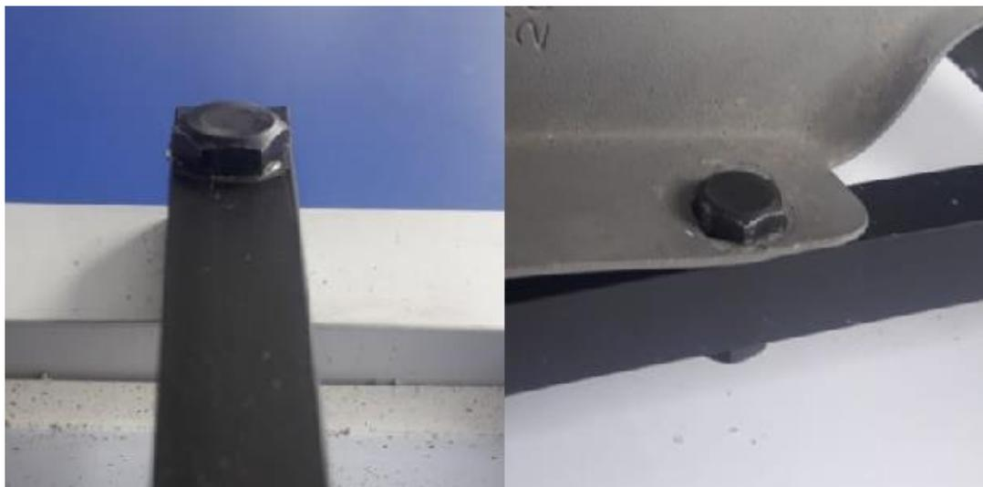
**Figura 48. Sujeción de columna con panel y columna con pedestal angular. Autoría Propia**
