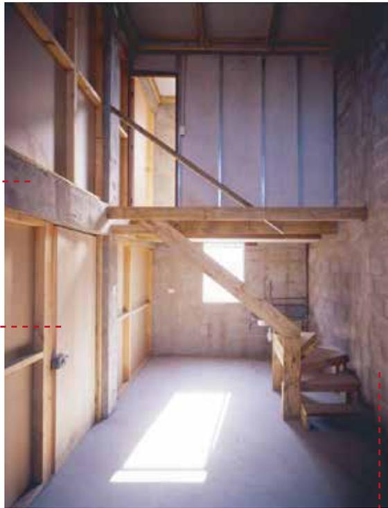
Bloques de concreto es utilizados entre medianeras
