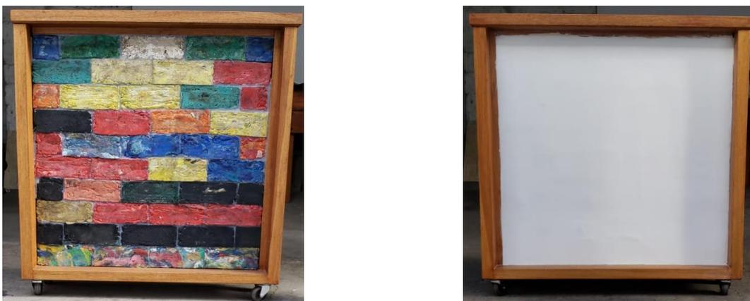
**Figura 54:** Unidad de ladrillo y pared de ladrillo visto y terminada con estuco y pintura
