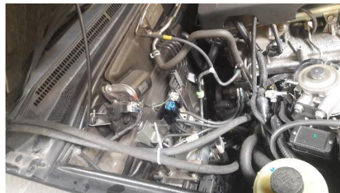
Figura 9. Instalación de las nuevas líneas de combustible
