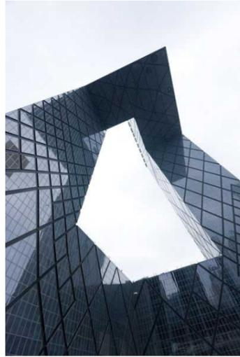
La estructura del edificio de la CCTV ha resultado ser un verdadero reto en ingeniería. Para su construcción fue necesario diseñar un plan para levantar las dos torres en una inclinación de 6 grados, siendo dobladas finalmente a 90 grados en su parte superior e inferior, uniéndose de esta manera frontalmente, formando un bucle continuo. El edificio fue construido inicialmente en dos secciones diferentes, que posteriormente fueron unidas para completar la estructura en diciembre de 2007.
