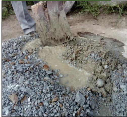
*Figura 5.* Preparación del hormigón
