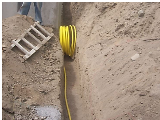
Figura 2. Tubería de polietileno lista a instalarse.
