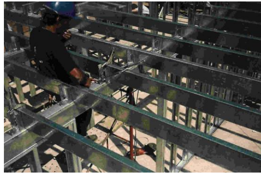
Fig. 8: Enrigado de piso METALCON
