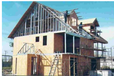
Fig.3: Vivienda de 2 pisos más mansarda, estructurada en METALCON
