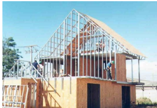
Fig. 9: Estructura de techo METALCON
