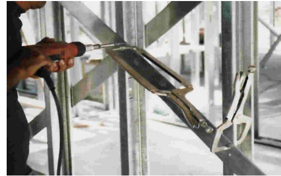
Fig. 5: Perfiles de acero galvanizado
