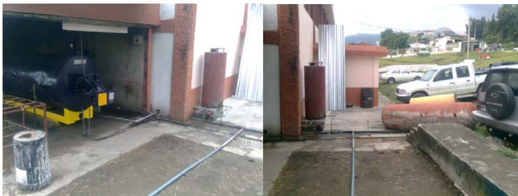
Gráfico 4.8: Caldero en el exterior del camal.
