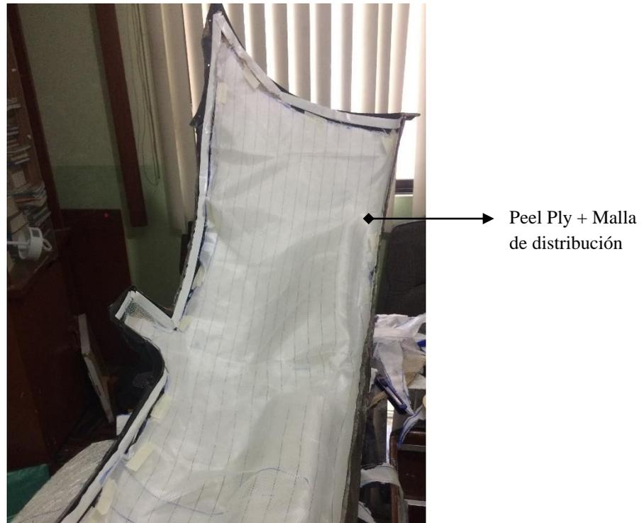
Figura 68. Peel Ply y malla de distribución sobre las fibras utilizadas como refuerzo.
