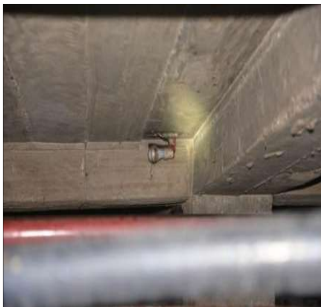
Fotografía 13: Luminarias del Subsuelo del área de tanques
