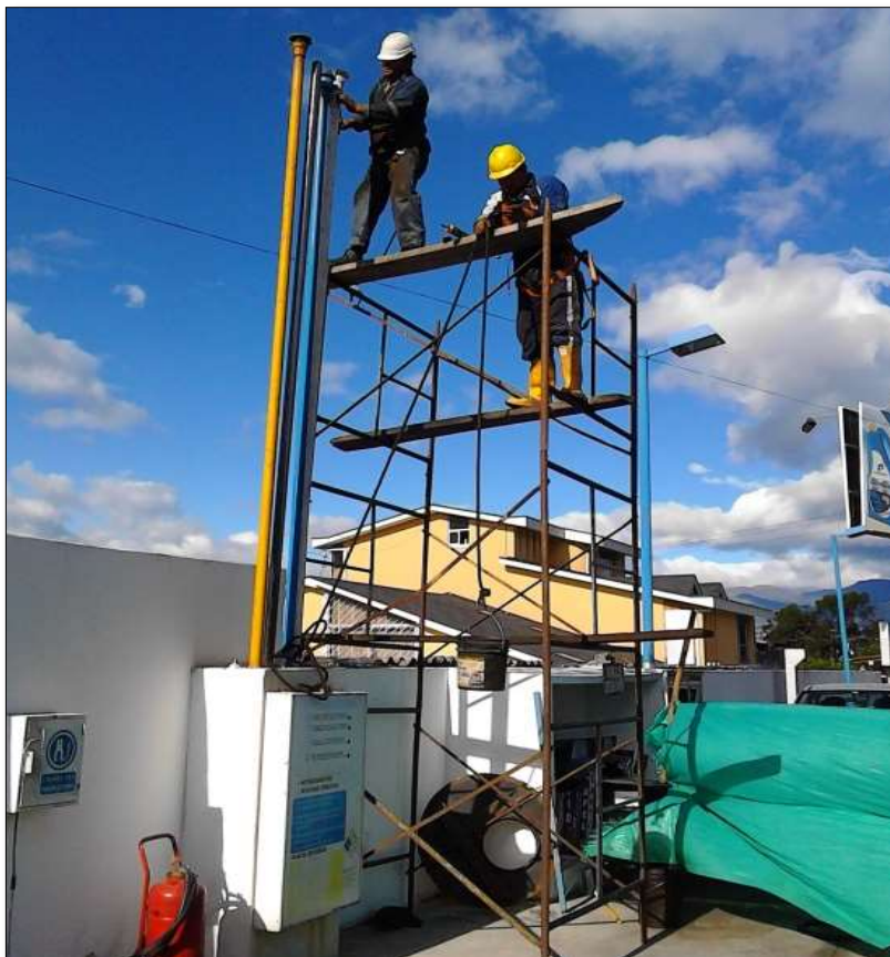
Fotografía 3: Mantenimiento de tubos y válvulas de venteo
