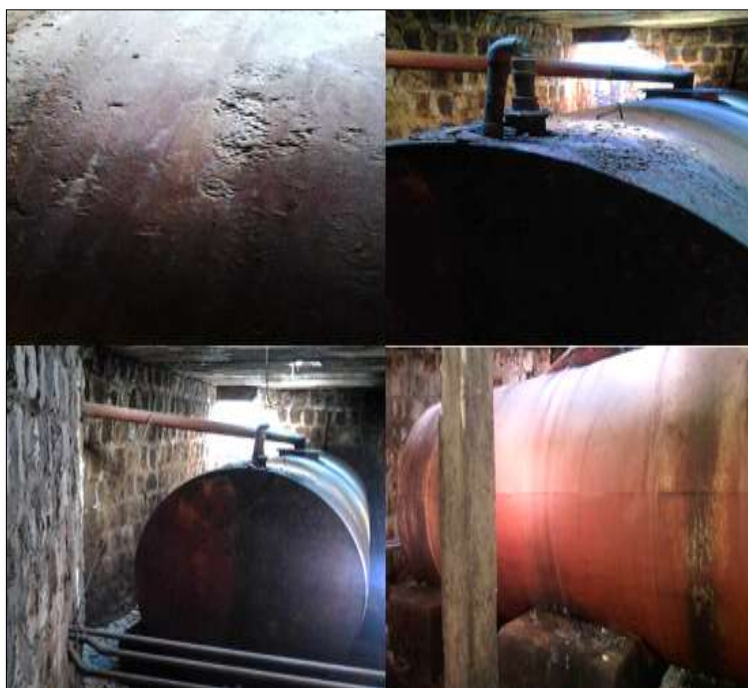
Fotografía 10: Tanque de Almacenamiento subterráneo
