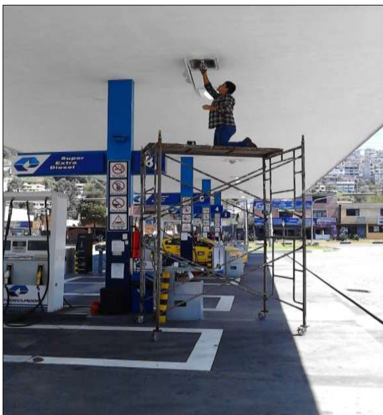
Fotografía 1: Cambio de luminarias en marquesina
