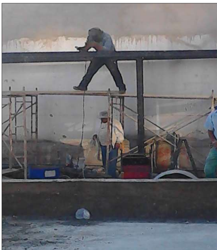
Fotografía 2: Trabajos de soldadura
