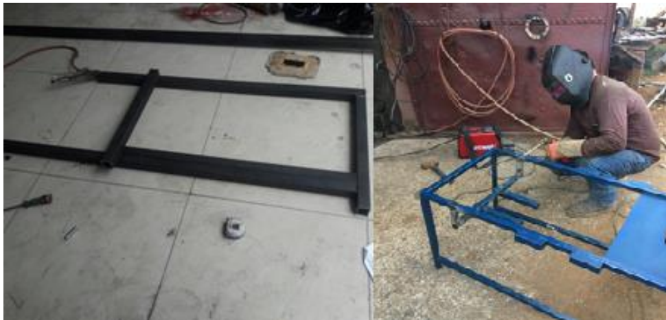
Figura 77. Construcción de un módulo estructural
