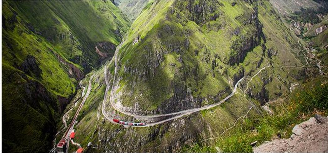
30 curvas talladas en roca en un tramo de 11 kilómetros con un desnivel de 1300 metros...suficiente para que esta línea férrea fuera conocida como "el tren más difícil del mundo"
