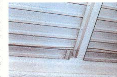
Cubierta metálica protegida con un producto de prevención de incendios
