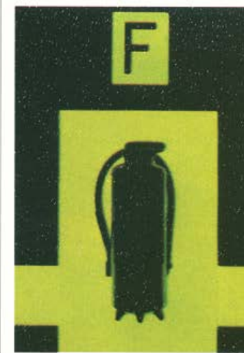
Extintor de pared cuyo contorno se ha pintado con materiales que brillan en la oscuridad.
