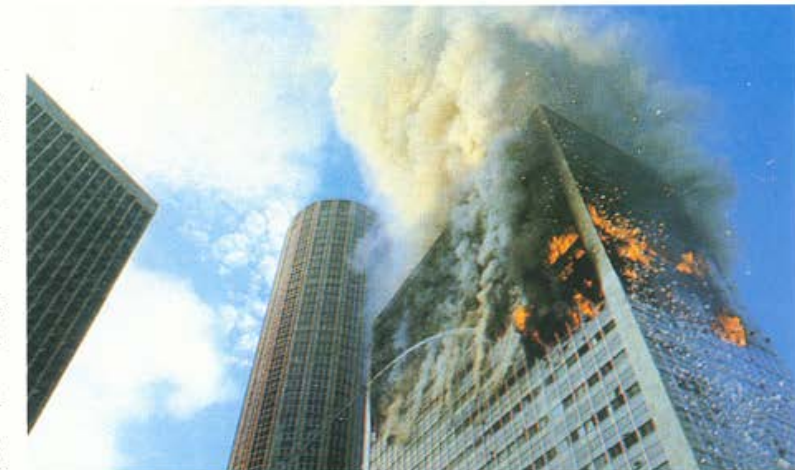
Las medidas a tomar para evitar incendios son de prevención y de protección.
