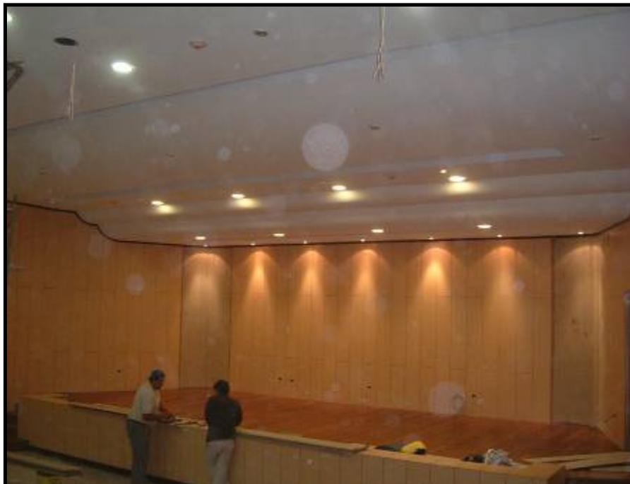
**2.4.4.2 Paredes.-** se utiliza la perfilera principal de acuerdo a especificaciones técnicas, para obtener una estructura fuerte y resistente, sobre la cual se anclaran las planchas de gypsum para conformar la pared.
