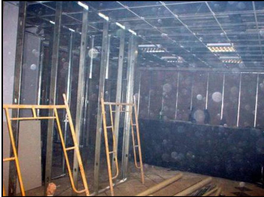
Una vez anclada las planchas a la estructura principal y de acuerdo a especificaciones técnicas, se procede a dar el acabado con material de estuco y pintura como se muestra a continuación:
