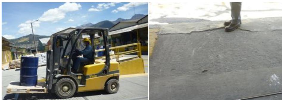
**Fig.4.11.** Superficie de contacto irregular para la circulación del montacargas.
