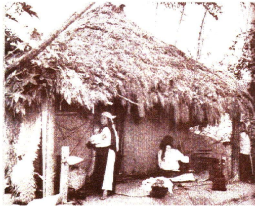
Foto #6: Casa hecha de adobe cubierta con paja
