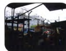
Foto 57: Circulaciones verticales usadas como bodegas
