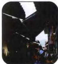
Foto 32: Cubiertas sector abierto.
