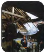
Foto 33: Cubiertas sector abierto.
