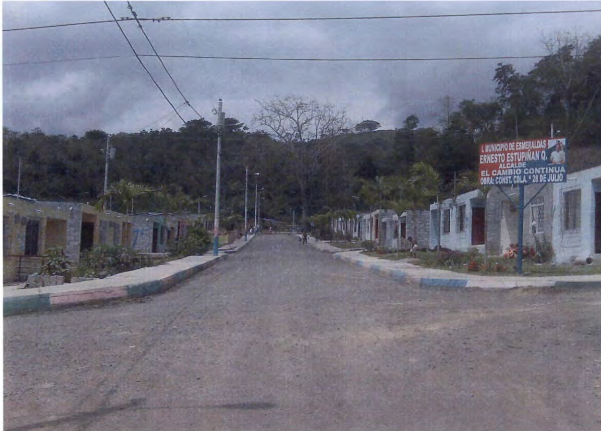
VISTAS DEL EQUIPAMIENTO REASENTAMIENTO BARRIO 28 DE JULIO ESMERALDAS
