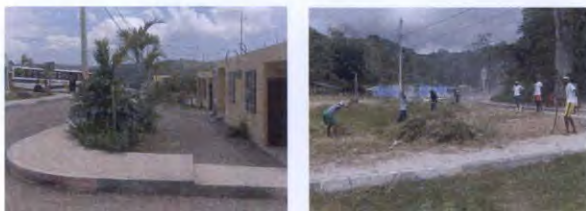
VISTAS DEL EQUIPAMIENTO REASENTAMIENTO CUSUA - CHACAUCO PELILEO
