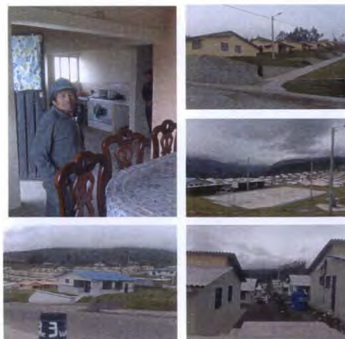
VISTAS DEL EQUIPAMIENTO REASENTAMIENTO CUSUA - CHACAUCO PELILEO
