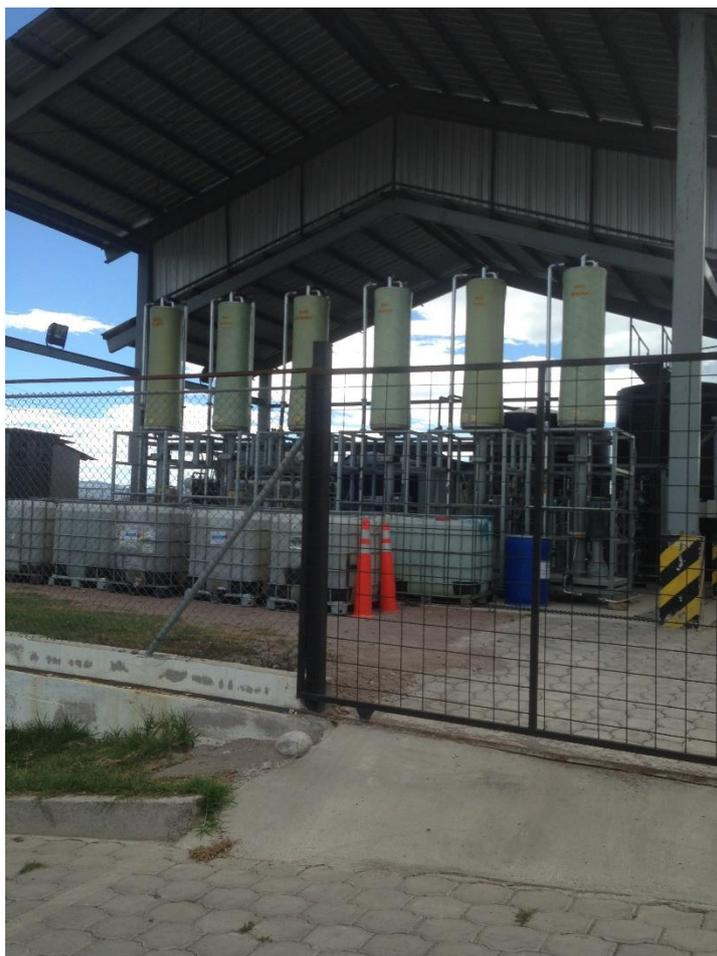
**Fotografía 5: Planta de tratamiento de lixiviados VSEP del Relleno Sanitario Q.**
