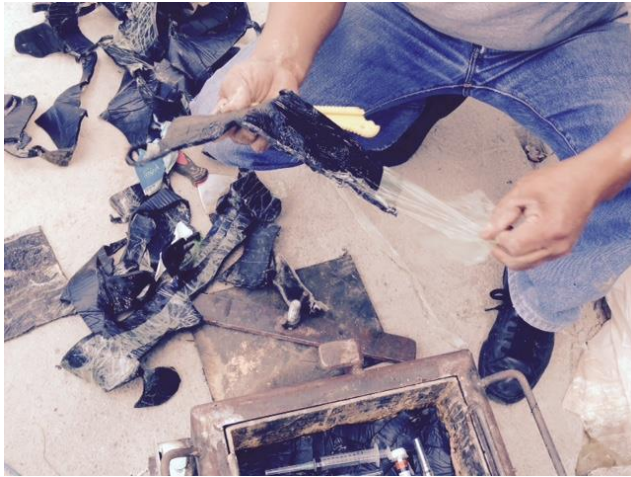
Ilustración # 15. Retiro de Polietileno
