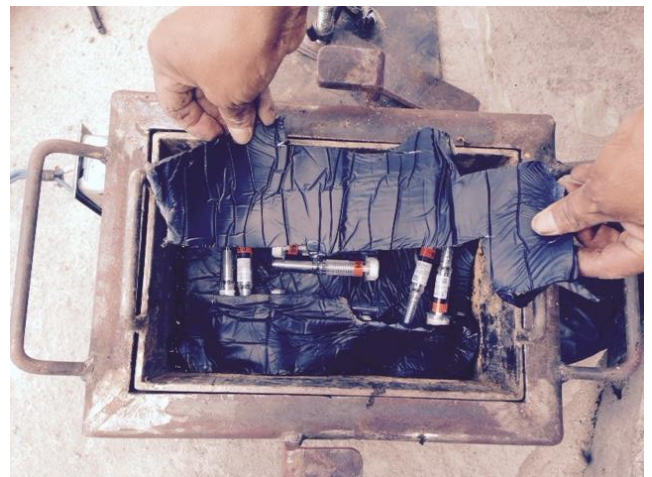
Ilustración # 16. Colocación láminas ATR Autoadhesivas
