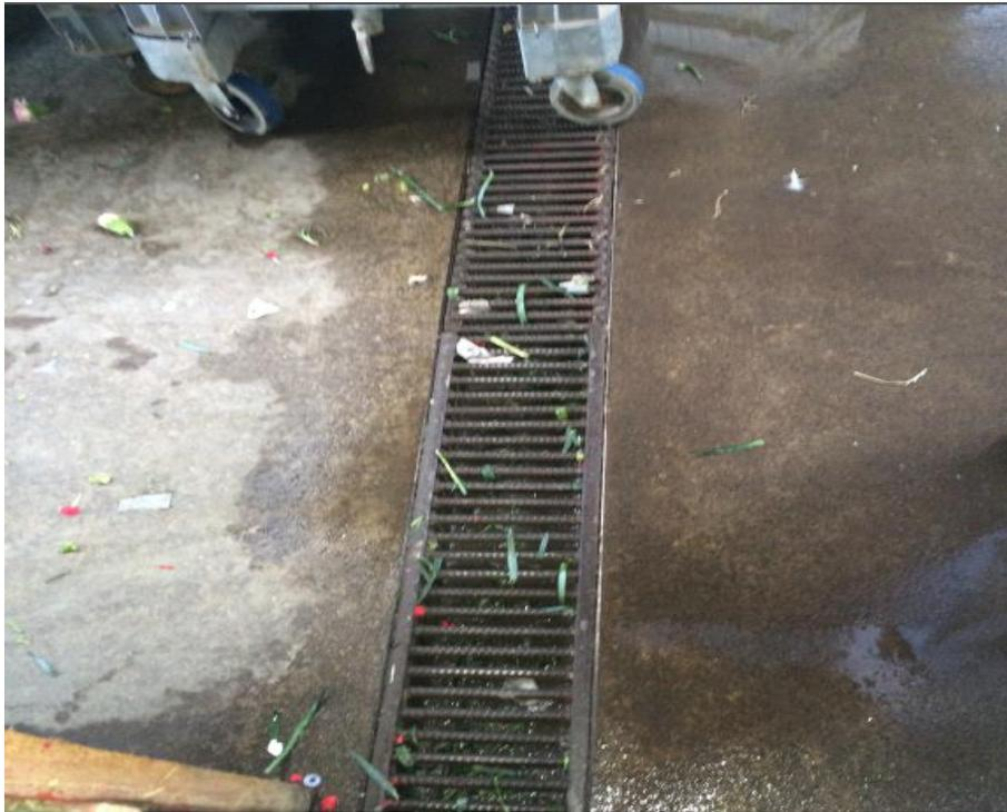
Imagen 13. Sistema de evacuación de aguas residuales en sala de poscosecha
