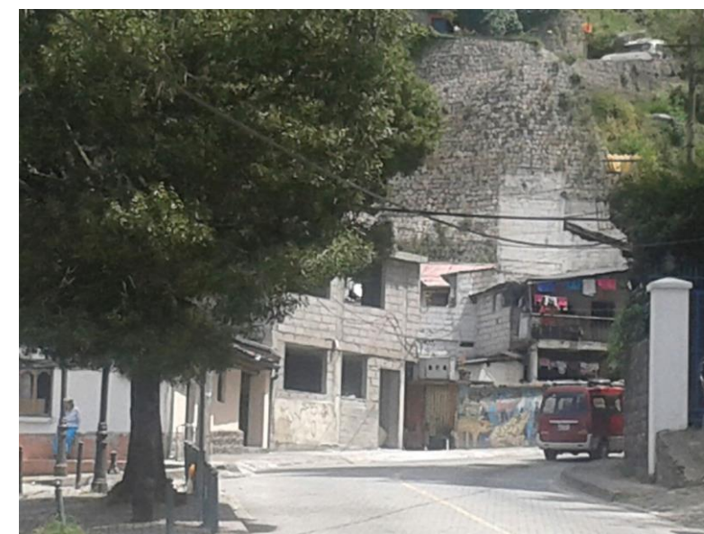
Imagen 79. Edificaciones localizadas en el área de intervención
