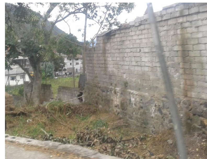
Imagen 78. Edificaciones localizadas en el área de intervención
