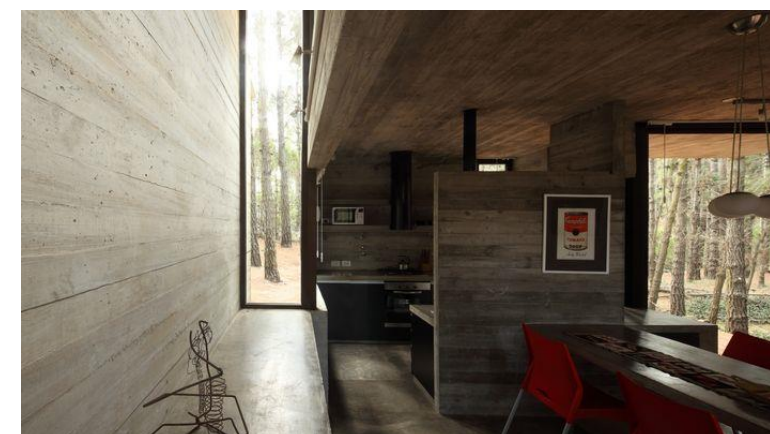
Imagen 98. Acabado del hormigón visto
