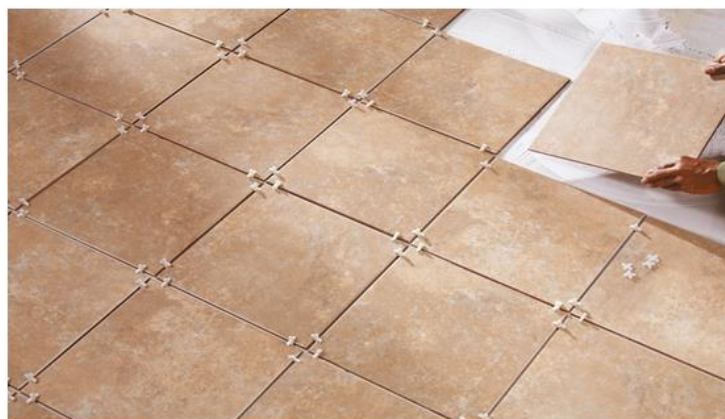
Imagen 112. Instalación de pisos de cerámica
