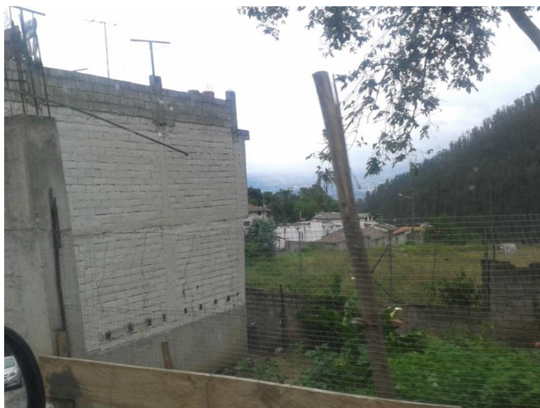
Imagen 81. Edificaciones localizadas en el área de intervención
