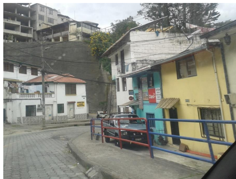
Imagen 77. Edificaciones localizadas en el área de intervención
