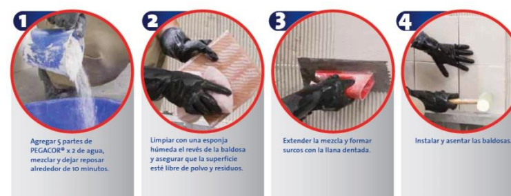
Imagen 120. Proceso de Instalación de porcelanato.
