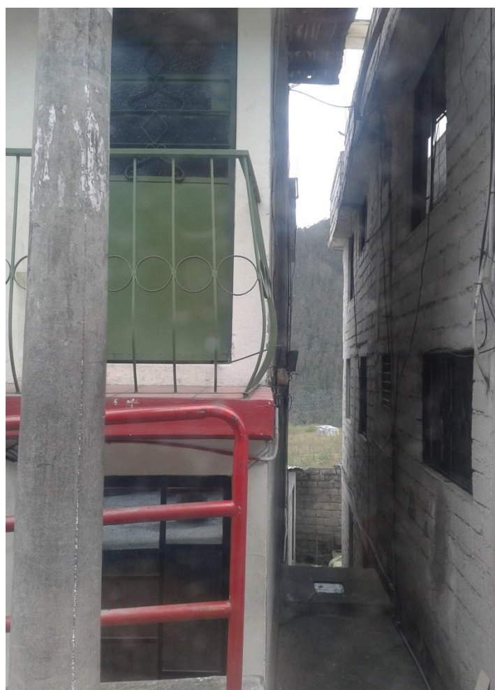
Imagen 75. Edificaciones localizadas en el área de intervención.
