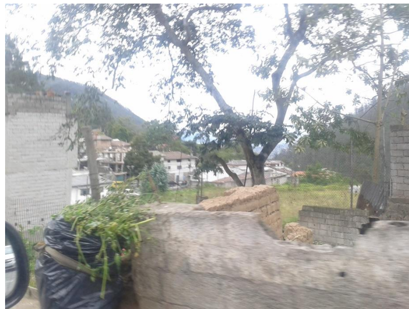
Imagen 76. Edificaciones localizadas en el área de intervención
