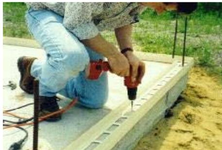
3. Instalación del andamiaje para sostenimiento temporal de los muros .- Sirve para soportar los muros de PVC durante el ensamblaje y vaciado del concreto. El andamiaje se compone de 5 piezas principalmente: La base de fijación, el soporte del andamiaje, la escuadra de tablón, el puntal y el perfil de acero en "Z". Las bases del andamiaje deben
