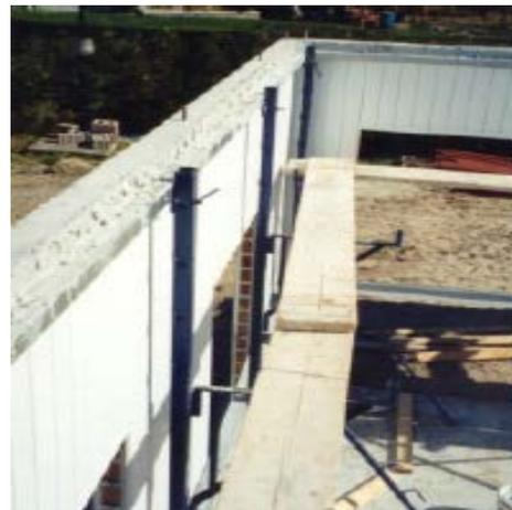
El concreto de los muros debe tener una resistencia de 20 MPA con un asentamiento máximo de 20 cm y un agregado de 20 mm.
