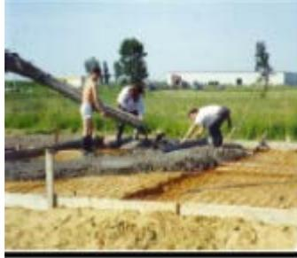
2. Colocación de las soleras sobre la losa de cemento.- Consiste en trazar y colocar las soleras para los muros exteriores e interiores. Las soleras son suministradas con una longitud de 5 metros y deben ser cortadas de acuerdo a su necesidad con una sierra eléctrica. Antes de que las soleras sean fijadas a la placa, es necesario colocar un sellador o enlucido bituminoso hecho con una cinta de polietileno. Para fijar las soleras a la losa se debe utilizar tornillos para concreto.
