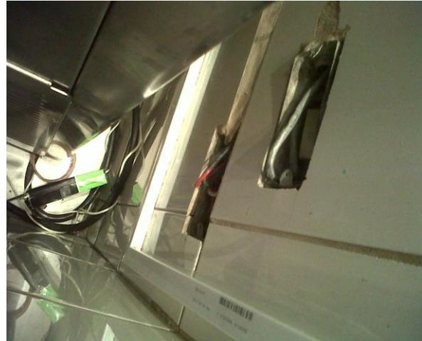
Las instalaciones eléctricas se encuentran desgastadas y requieren ser puestas en mantenimiento y reemplazadas como se observa, existen cables pelados instalaciones desprotegidas, cajas de interruptores sin identificación ni la señalética correspondiente.
