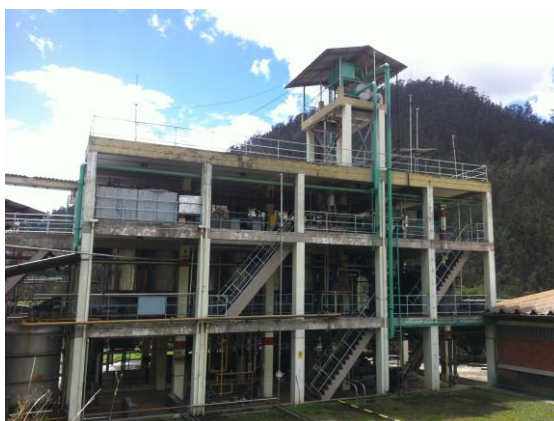
Figura 6. Vista lateral de la planta 2
