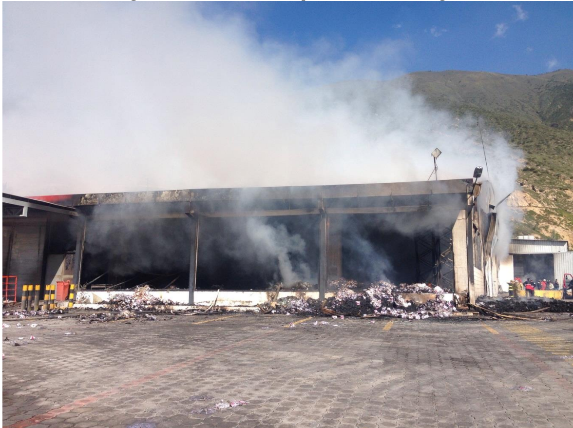
Figura 4: Daños ocasionados por incendios en bodegas
