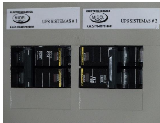
Fig. #9 Tableros de Distribución de Cuarto de Servidores y Aire Acondicionado. Realizado por: Patricia Malitasig
