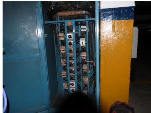
Fig. #8 Sub tablero de distribución para el Cuarto de Servidores Realizado por: Patricia Malitasig
