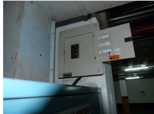
Fig. #8 Sub tablero de distribución para el Cuarto de Servidores Realizado por: Patricia Malitasig
