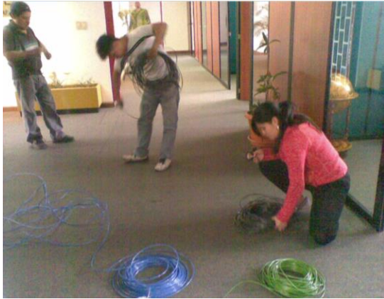
Fig. #37 Preparación de cable y ponchado de puntos de red Realizado por: Patricia Malitasig
