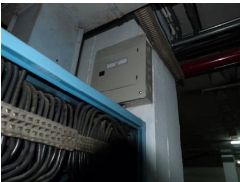
Fig. #8 Sub tablero de distribución para el Cuarto de Servidores Realizado por: Patricia Malitasig
