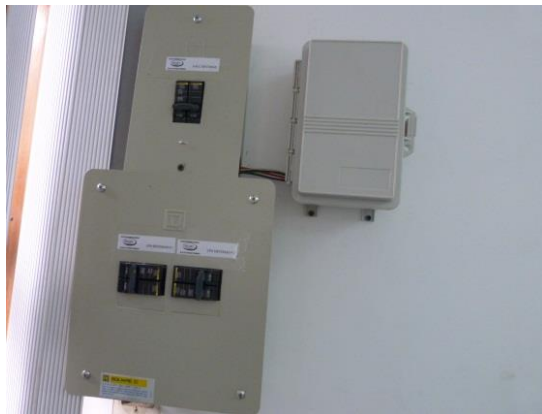
Fig. #9 Tableros de Distribución de Cuarto de Servidores y Aire Acondicionado. Realizado por: Patricia Malitasig
