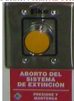
Figura 32: Pulsador Manual de Aborto Fuente: Memoria Técnica Fike
