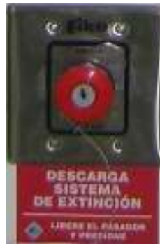
Figura 31: Pulsador Manual de Descarga del Agente Fuente: Memoria Técnica Fike
