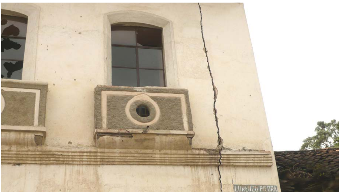
Agrietamiento vertical en fachada, vista desde calle L. Piedra
