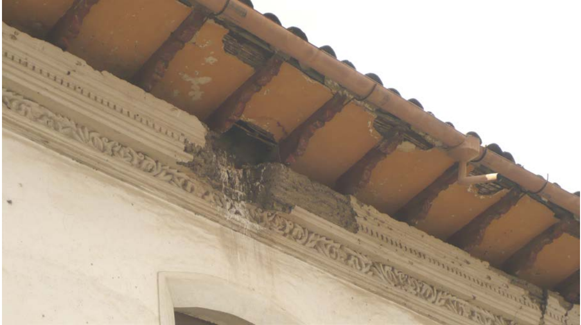
Incidencia de las filtraciones de humedad en aleros y paredes
