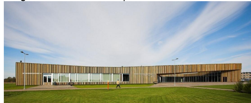
Imagen # 35 Fachada Principal
