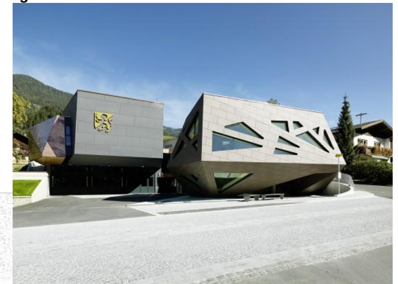
Imagen # 17 Centro Comunitario en AbfALTERSBACH
